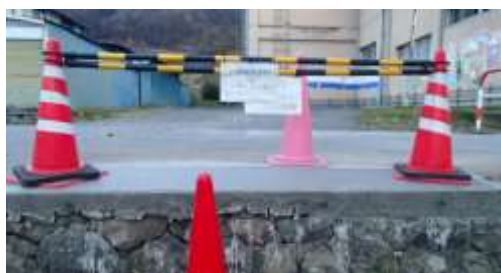
校庭の校舎側 石垣 (斜めに傾いていたものをまっすぐに)
