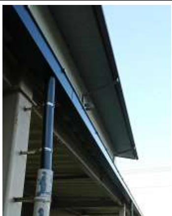
体育館 雨どい (新しく付け替え)
