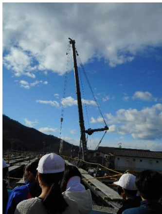
神川橋建設現場見学(6年生)
