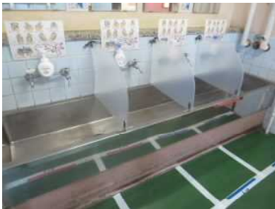
仕切り板をつけた手洗い場
