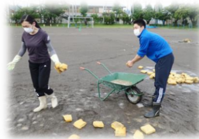
早朝からの水抜き作業
