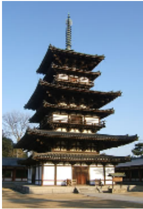
薬師寺三重塔（東塔）
