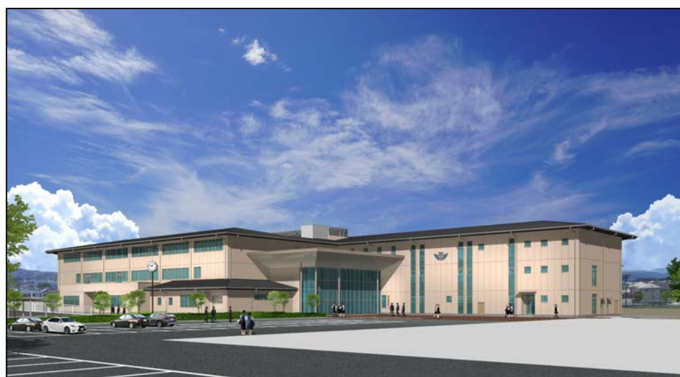
大屋根のある昇降口 (体育館北側からの外観)
