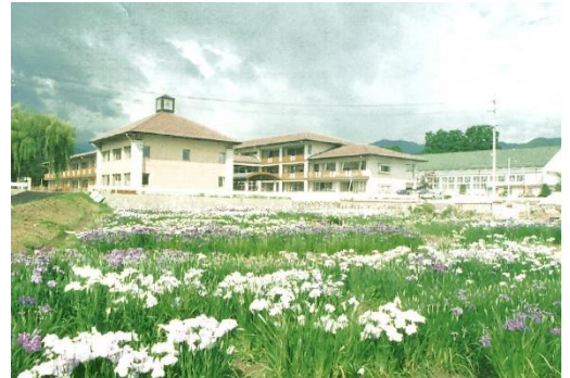
平成8年 新校舎完成
