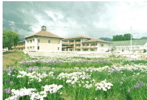
平成8年 新校舎完成
