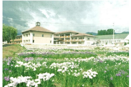
平成8年 新校舎完成
